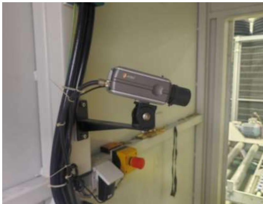
图 10-3 X 射线检测系统内部视频监控摄像头位置
