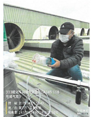
303 硫化车间排气筒出口 DA045 (18号排气筒)
