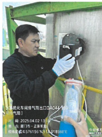
306 硫化车间排气筒出口 DA044 (30 号排气筒)
