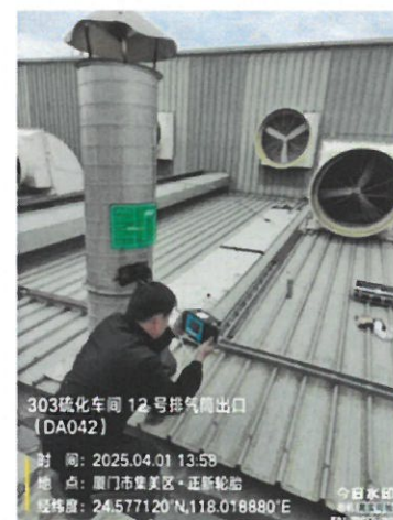
303 硫化车间排气筒出口 DA042 (12 号排气筒)
