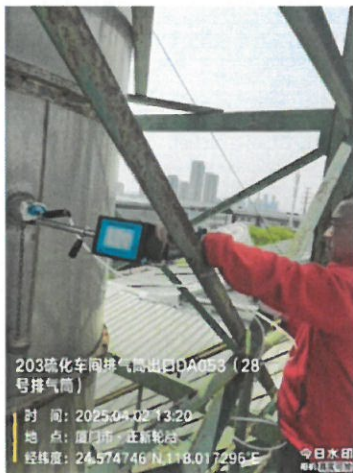
203 硫化车间排气筒出口 DA053 (28 号排气筒)
