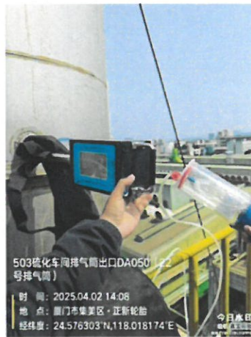
503 硫化车间排气筒出口 DA050 (22号排气筒)
