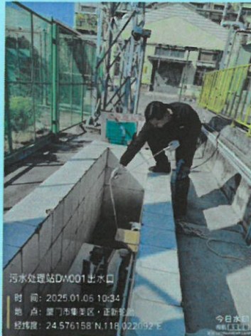
污水处理站 DW001 出水口
