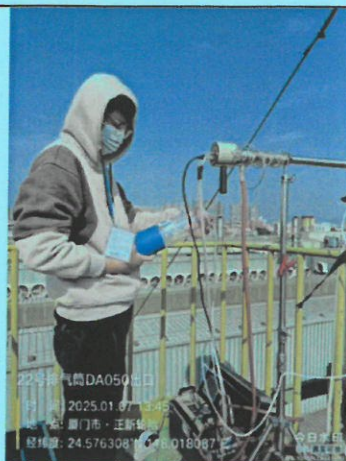
503 硫化车间排气筒出口 DA050 (22 号排气筒)
