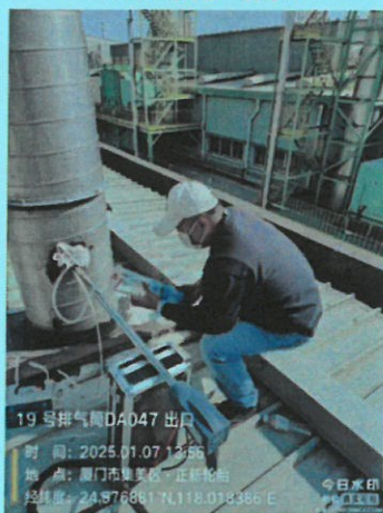
303 硫化车间排气筒出口 DA047 (19 号排气筒)
