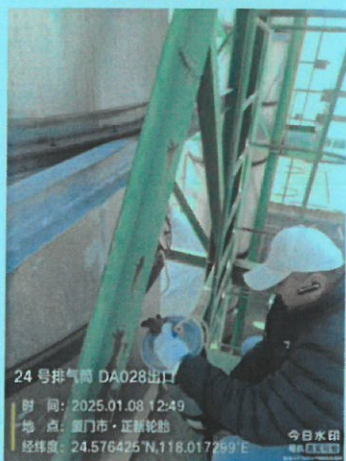
504 硫化车间排气筒出口 DA028 (24 号排气筒)
