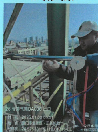
203 硫化车间排气筒出口 DA036 (26 号排气筒)
