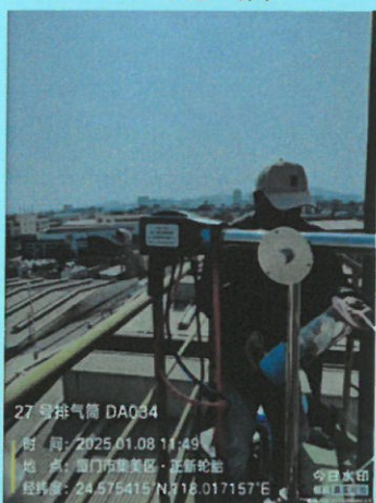
203 硫化车间排气筒出口 DA034 (27 号排气筒)
