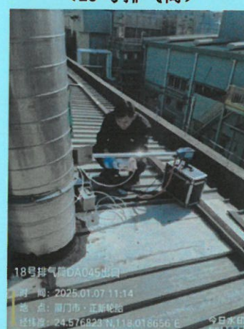
303 硫化车间排气筒出口 DA045 (18 号排气筒)
