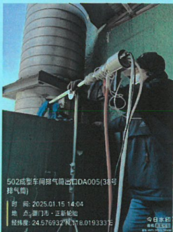
502 成型车间排气筒出口 DA005 (38 号排气筒)
