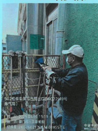
502 检修车间排气筒出口 DA022 (49 号排气筒)
