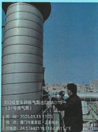
302 成型车间排气筒出口 DA010 (37 号排气筒)
