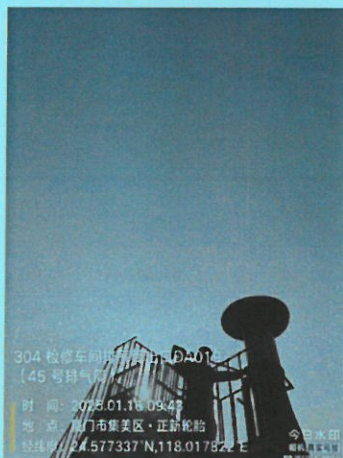
304 检修车间排气筒出口 DA019 (45 号排气筒)
