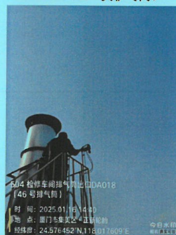
504 检修车间排气筒出口 DA018 (46 号排气筒)
