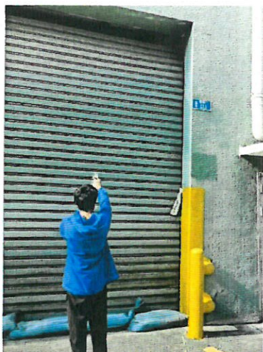
501 车间北侧大门外 1 米
