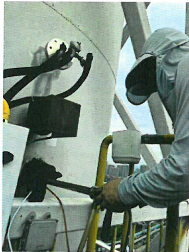
501 混炼车间排气筒出口 (DA003)
