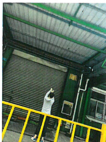
101 车间西侧大门外 1 米
