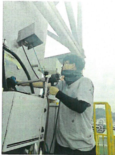
01 混炼车间排气筒出口 (DA001)
