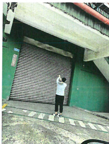
101 车间南侧大门外 1 米
